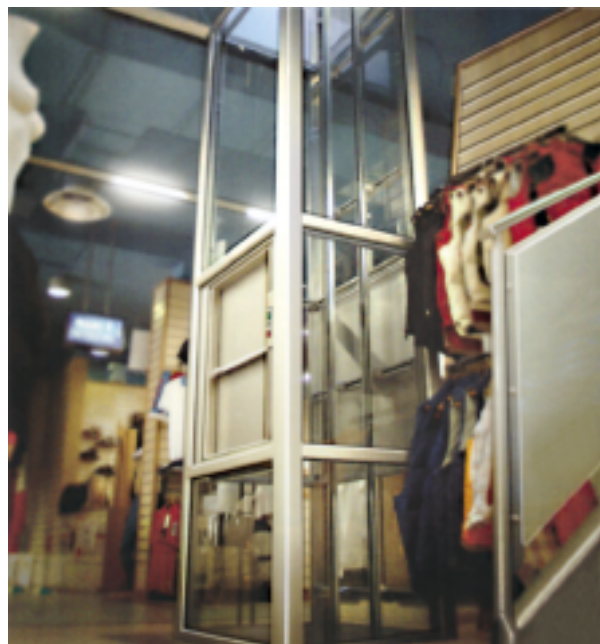
Instalație montată într-un magazin de îmbrăcăminte, model 50 kg, placată cu sticlă. Cabina este standard, vopsită în culoarea RAL 7038.
