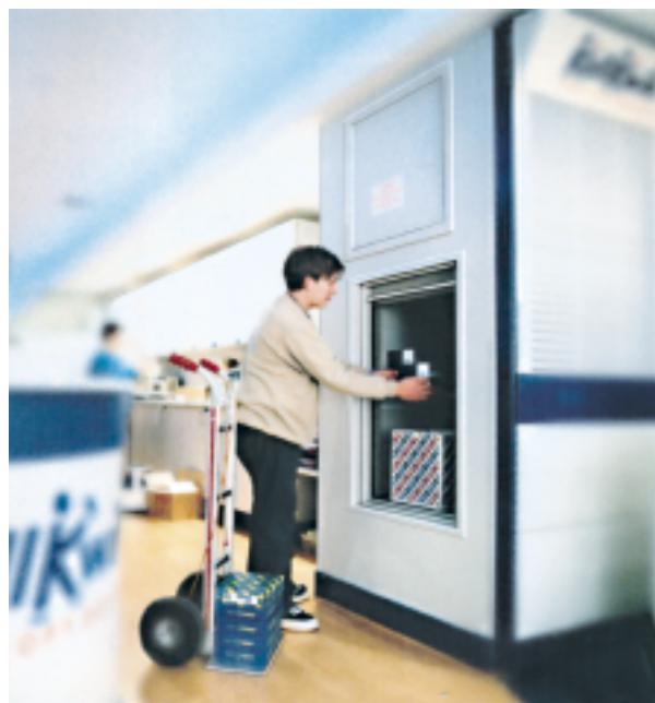
Instalație montată într-un centru de fotocopiere, model 100 kg. Cabina și ușile sunt din inox AISI 304.
