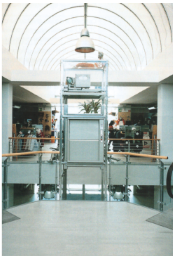
Instalație montată într-un magazin de îmbrăcăminte sport, model 50 kg, compartimentul este placat cu sticlă și cabină standard vopsită în culoarea RAL 7038.
