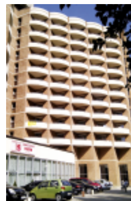
Echipament instalat: 2 ascensoare electrice, 6 pers., 13 stații; 13 pers., 14 stații Locație: Complex Hotelier Afodita, Băile Herculane Client: RESTAURANT BACOLUX
