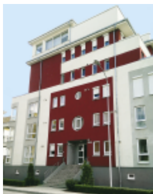
Echipament instalat: Ascensor 300 kg., 2 stații Locație: Str. Albatros, nr. 11 Brașov Client: MAURER IMOBILIARE
