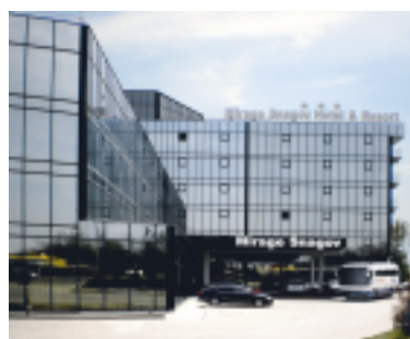
Echipament modernizat: 1 ascensor hidraulic, 4 pers., 7 stații 3 ascensoare electrice, 8 pers., 8 stații (2); 100 kg, 2 stații 1 ascensor hidraulic Locație: Șos. București-Ploiești, nr. 218, com. Tâncăbești, jud. Ilfov Client: HOTEL MIRAGE
