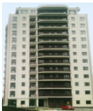
Echipament instalat: 2 ascensoare electrice, 10 pers., 14 stații Locație: str. Depozitelor, nr. 29 C Pitești Client: TRANSIM GRUP
