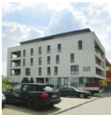
Echipament instalat: Ascensor hidrolic, 6 pers., 5 stații Locație: Str. Petricani nr. 3 F, sect. 2, București Cliant: ALDO SECURITY TOP
