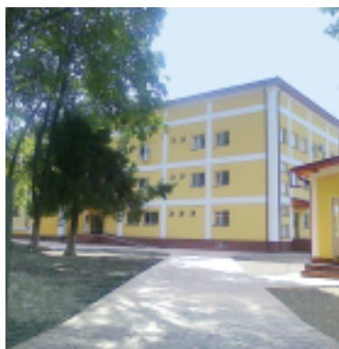
Echipament instalat: Ascensor hidrolic, 20 pers., 4 stații; Ascensor electric, 100 kg, 4 stații Locație: Str. Floare Roșie, nr. 7 A sect. 6, București Client: TFT INVEST
