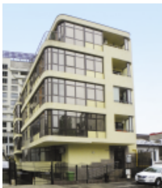
Echipament instalat: Ascensor hidrolic, 4 pers., 6 stații Locație: Str. Popa Stoica Fărcaș, nr. 86-88, sect. 3, București Cliant: PRODION SERVICE
