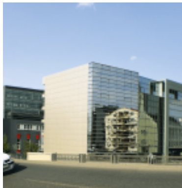
Echipament instalat: Ascensor hidrolic, 4 pers., 7 stații Locație: Str. Pechea, nr. 11 A, sect. 1, București Client: CIUCĂ GHEORGHE
