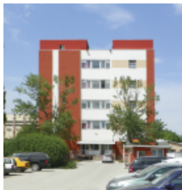
Echipament instalat: 2 ascensoare electrice, 6 pers., 5 stații; 13 pers., 6 stații Locație: Calea Giulești, nr. 6-8, sect. 6, București Cliant: PALEX CONSTRUCȚII INSTALATII
