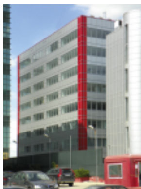
Echipament instalat: 4 ascensoare electrice, 8 pers., 10 stații (2); 8 pers., 11 stații (2) Locație: Șos. Pipera-Tunari, nr. 1, sect. 2, București Client: ADEXIM MODELCOM
