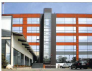
Echipament instalat: Ascensor hidrolic, 8 pers., 5 stații Locație: Str. Republicii, nr. 152, Ploiești Client: BT LEASING TRANSILVANIA IFN
