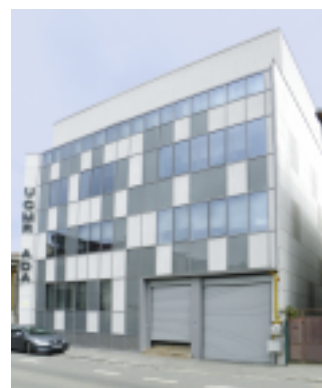
Echipament instalat: Ascensor hidrolic, 6 pers., 5 stații Locație: Str. Ostașilor, nr. 12, sect. 1, București Cliant: DAC ANTREPRIZA CONSTRUCTII
