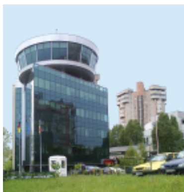
Echipament instalat: Ascensor marfă, 375 kg, 2 stații Locație: Str. Traian, nr. 68 A, Constanța Cliant: NBC LINE
