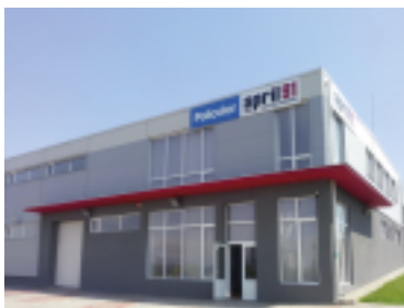
Echipament instalat: Ascensor marfă, 1000 kg, 2 stații Locație: Cartier Ernei, str. Principală, Târgu Mureș Cliant: SC APRIL 91 SRL
