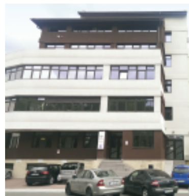
Echipament instalat: Ascensor hidrolic, 4 pers., 4 stații Locație: Str. Mărășești, nr. 19, Ploiești Client: ANALIZING MARKET DATE
