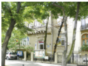
Echipament instalat: Ascensor hidrolic, 4 pers., 3 stații Locație: Bd. Lascăr Catargiu, nr. 23, sect. 1, București Cliant: IL MAKIAGE
