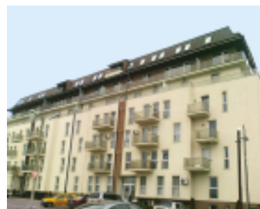
Echipament instalat: 2 ascensoare electrice, 6 pers., 7 stații Locație: Str. Gării, nr. 1, bl. 2, com. Dobroiești-Fundeni, Jud. Ilfov Client: URBAN EXPERT CONSTRUCT
