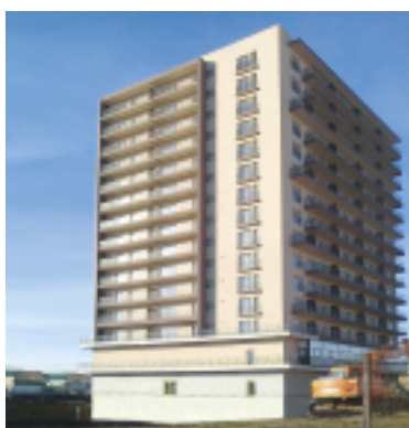
Echipament instalat: 3 ascensoare electrice, 6 pers., 16 stații; 13 pers., 16 stații; 13 pers., 2 stații Locație: Bd. Timișoara, nr. 91, sect. 6, București Client: ALL PLAN CONSTRUCTION
