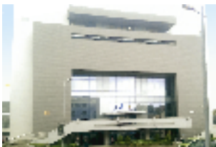
Echipament instalat: 3 ascensoare electrice, 8 pers., 7 stații; 8 pers., 3 stații; 2 pers., 6 stații Locație: str. I.C. Brătianu, nr. 7, Pitești Client: CONARG CONȘTRUCT TRIBUNALUL ARGEȘ
