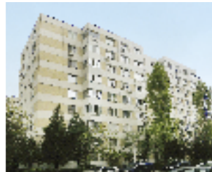
Echipament modernizat: 2 ascensoare electrice, 4 pers., 9 stații Locație: Str. Prevederii, nr. 1, bl. PM 4, sect. 3, București Client: ASOCIAȚIA DE PROPRIETARI
