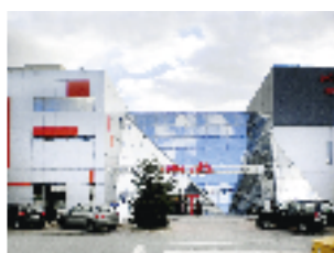
Echipament instalat: Ascensor electric 20 pers., 4 stații Echipament modernizat: Ascensor electric 13 pers., 3 stații Locație: Str. Erou lăncu Nicolae, nr. 103 bis, com. Voluntari, jud. Ilfov Client: JOLIE VILLE
