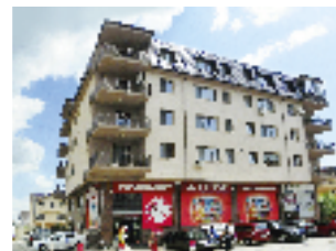
Echipament instalat: Ascensor hidrolic, 5 pers., 6 stații Locație: Str. Doinei, nr. 80, com. Dobroiești, jud. Ilfov Client: CRYBAD CONSTRUCT COMPANY
