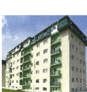
Echipament instalat: Ascensor hidrolic, 6 pers., 5 stații Locație: Str. Drumul belșugului, nr. 33-43, sect. 6, București Client: ZANFIR SEVER
