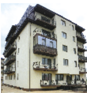
Echipament instalat: Ascensor hidrolic, 6 pers., 6 stații Locație: Intrarea Cireșului, nr. 11, com. Dobroești, jud. Ilfov. Client: NICULAE VASILE DĂNUȚ
