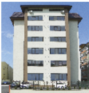
Echipament instalat: Ascensor hidrolic, 6 pers., 7 stații Locație: Str. Valea Oltului, nr. 37-41, sect. 6, București Client: DORIN CONSTRUCT
