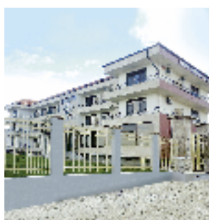
Echipament instalat: Ascensor hidrolic, 6 pers., 3 stații Locație: Str. Pescărușului, com. Limanul, sat Vama Veche, jud. Constanța Client: IONESCU COSMIN
