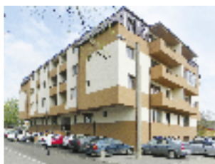
Echipament instalat: Ascensor hidrolic, 6 pers., 4 stații Locație: Str. Lacul Mare, nr. 12-12A-14, sect. 5, București Client: P.F.A. MANOLESCU MARCEL
