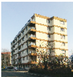
Echipament instalat: Ascensor hidrolic, 6 pers., 7 stații Locație: Aleea Lacul Dâmbovița, nr. 28, com. Roșu, jud. Ilfov Client: FLORIN MANEA
