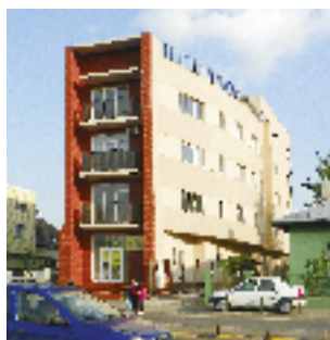
Echipament instalat: Ascensor hidrolic, 6 pers., 6 stații Locație: Calea 13 septembrie, nr. 207 A, sect. 5, București Client: GROSU MIHAELA DACIANA
