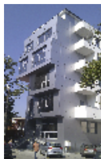
Echipament instalat: Ascensor hidrolic, 6 pers., 5 stații Locație: Str. Dezrobirii, nr. 13, sect. 6, București Client: ION CORNEL PETRUȚ, CLINICA POLIMED-APACA
