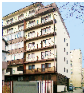
Echipament instalat: Ascensor hidrolic, 4 pers., 6 stații Locație: Str. Amurgului, nr. 43 A, sect. 5, București Client: DOREMIT
