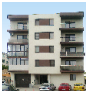
Echipament instalat: Ascensor hidrolic, 4 pers., 6 stații Locație: Str. Theodor Speranția, nr. 54, bl. C 2, Constanța Client: LUIGI TOFAN
