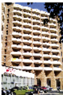
Echipament instalat: 2 ascensoare electrice, 6 pers., 13 stații; 13 pers., 13 stații Locație: Complex Hotelier Afodita, Băile Herculane Client: RESTAURANT BACOLUX
