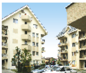
Echipament instalat: 2 ascensoare hidraulice, 3 pers., 5 stații Locație: Str. Drumul Fermei, nr. 103, lot 4, București Client: KLUG INVEST
