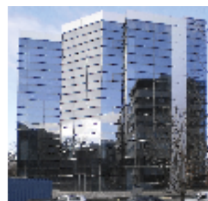
Echipament instalat: 2 ascensoare electrice, 7 pers., 6 stații Locație: Str. Sfântu Dumitru, nr. 8, Craiova Client: POLYSTART IMPEX
