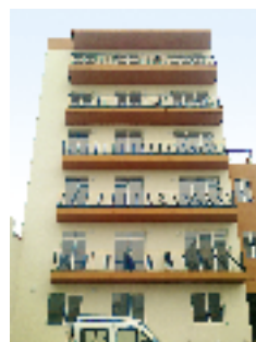
Echipament instalat: 2 ascensoare electrice, 4 pers., 7 stații; 5 pers., 7 stații Locație: Str. Dragoș Vodă nr. 82, sect. 2, București Client: BORCEA DESIGN CONSTRUCT
