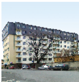
Echipament instalat: 2 ascensoare electrice, 5 pers., 9 stații Locație: Str. Mărgelilor, nr. 11, sect. 6, București Client: CONSTANTIN COSTEA
