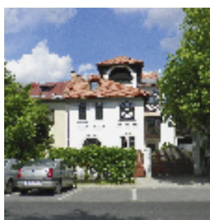
Echipament instalat: Ascensor hidrolic, 4 pers., 5 stații Locație: Str. Clucerului, nr. 40, sect. 1, București Client: BRODONA PRODUCT
