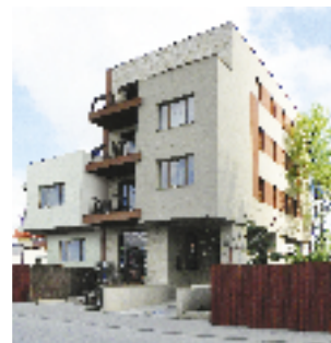
Echipament instalat: Ascensor hidrolic, 4 pers., 4 stații Locație: Str. Piscul Crășani, nr. 2 D, sect. 6, București Client: STOLERU VALENTIN
