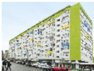
Echipament modernizat: 2 ascensoare electrice, 3 pers., 10 stații Locație: Calea Șerban Vodă, nr. 43, bl. 2, sect. 4, București Client: ASOCIAȚIA DE PROPRIETARI
