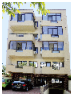
Echipament instalat: Ascensor hidrolic, 4 pers., 7 stații Locație: Str. Someșul Rece, nr. 79 (Ion Ionescu de la Brad), sect. 1, București. Client: DANIEL LUNGU
