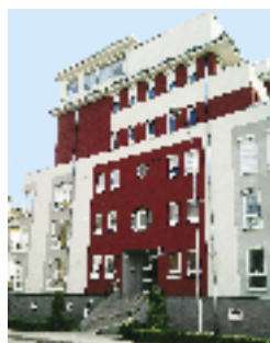
Echipament instalat: Ascensor 4 pers., 2 stații Locație: Str. Albatros, nr. 11 Brașov Client: MAURER IMOBILIARE
