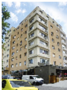
Echipament instalat: 2 ascensoare electrice, 6 pers., 11 stații; 5 pers., 11 stații Ascensor hidrolic 5 pers., 3 stații Locație: Șos. Colentina, nr. 408, sect. 2, București Client: BUCUREȘTI COM IMPEX
