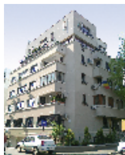
Echipament instalat: Ascensor hidrolic, 4 pers., 7 stații Locație: Str. Rosenthal, nr. 41, sect. 1, București Client: ISP VERIFICARI
