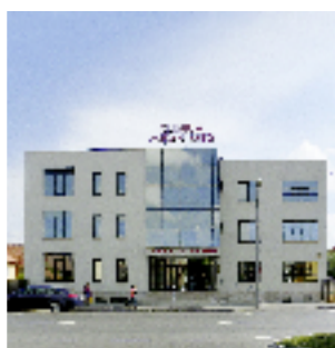
Echipament instalat: Ascensor electric 10 pers., 3 stații Locație: Str. Hipodromului nr. 3 B, Sibiu Client: CLINICA MISAN MED
