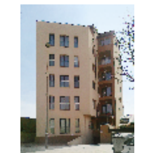
Echipament instalat: Ascensor hidrolic, 4 pers., 8 stații Locație: Str. Laminorului nr. 130, sect. 1, București Client: STOICAN IOSIF
