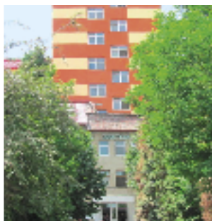
Echipament instalat: 5 ascensoare electrice, 4 pers., 8 stații; 6 pers., 8 stații; 21 pers., 8 stații (3) Locație: str. Simion Bărnuțiu, nr. 67, Zalău Client: TCI CG CLUJ, SPITALUL JUDEȚEAN DE URGENȚĂ
