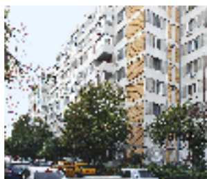
Echipament modernizat: 4 ascensoare electrice, 4 pers., 8 stații Locație: Str. Cernișoara, nr. 41, București Client: ASOCIAȚIE PROPRIETARI
