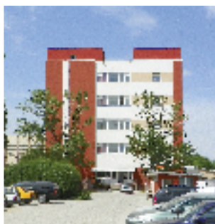
Echipament instalat: 2 ascensoare electrice, 6 pers., 5 stații; 13 pers., 5 stații Locație: Calea Giulești, nr. 6-8, sect. 6, București Client: PALEX CONȘTRUCȚII INSTALATII
