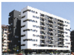
Echipament instalat: 2 ascensoare electrice, 5 pers., 10 stații Locație: Str. Tineretului, nr. 2, com. Chiajna Client: NVS INTERNATIONAL
