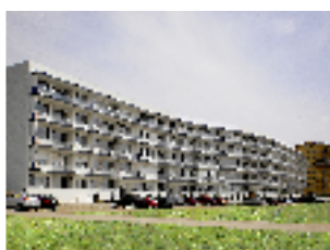
Echipament instalat: 5 ascensoare electrice 4 pers., 6 stații Locație: Str. Drumul Osiei, com. Chiajna, sat. Dudu, jud. Ilfov Client: NWF INTERNATIONAL
