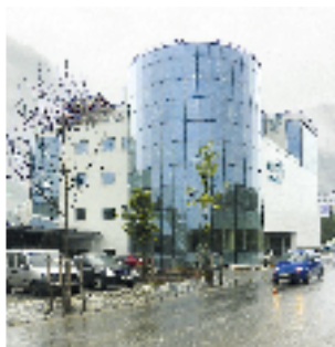
Echipament instalat: 2 ascensoare electrice, 6 pers., 6 stații; 6 pers., 5 stații Locație: Calea București nr. 3 A, com. Otopeni, jud. Ilfov Client: STANDARD-CM, MBT IMPOSSIBLE
