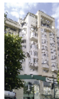
Echipament instalat: Înlocuire ascensor electric, 4 pers., 11 stații Locație: Bd. Unirii, nr. 62, bl. K 5, sc. 2, sect. 3, București Client: ASOCIAȚIA DE PROPRIETARI
