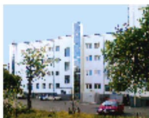
Echipament instalat: 2 ascensoare hidrolice, 150 kg, 3 stații; 100 kg, 2 stații Locație: Șos. Panduri, nr. 20, sect. 5, București Client: CLINICA "PROF. DR. TH. BURGHELE"
