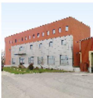
Echipament instalat: Ascensor hidrolic, 4 pers., 4 stații Locație: Str. Cernica nr. 47, com. Pantelimon, jud. Ilfov Client: G CANALE & C
