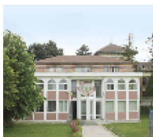
Echipament instalat: Ascensor hidrolic, 20 pers., 6 stații Locație: Str. I. C. Brătianu, nr. 54 B, Câmpulung Muscel Client: CLUBUL SĂNĂȚĂȚII
