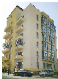
Echipament instalat: Ascensor hidrolic, 4 pers., 12 stații Locație: Str. Sabinelor, nr. 87, etaj 1, ap. 3, sect. 5, București Client: MEDICAL TECHNOLOGIES
