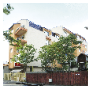
Echipament instalat: Ascensor hidrolic, 4 pers., 7 stații Locație: Str. Părgărilor, nr. 51-55, sect. 2, București Client: CONSTAR PROD
