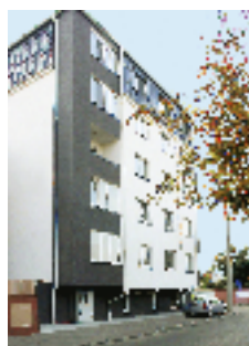
Echipament instalat: Ascensor hidrolic, 4 pers., 5 stații Locație: Str. Teiuș, nr. 11, sect. 5, București Client: BURCEA GABRIEL
