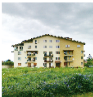
Echipament instalat: Ascensor hidrolic, 4 pers., 5 stații Locație: Str. Știrbei Vodă, nr. 32 D, bl. B1, Craiova Client: CONDURAT CRISTIAN-OVIDIU
