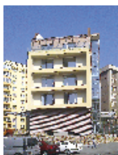
Echipament instalat: 2 ascensoare electrice, 8 pers., 5 stații; 6 pers., 6 stații Locație: Str. Victoriei, nr. 5, Brașov Client: BENDEI IOAN
