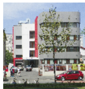
Echipament instalat: 3 ascensoare hidrolice, 20 pers., 4 stații; 100 Kg, 5 stații (2) Locație: Str. Dezrobirii, nr. 27-29, sect. 6, București Client: DELAR PARTENER, SPITALUL ORTOCLINIC DE COPII
