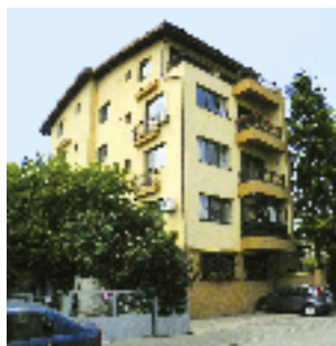
Echipament instalat: Ascensor hidrolic, 4 pers., 5 stații Locație: Str. Parângului, nr. 43 A, sect. 1, București Client: STAN SIMON
