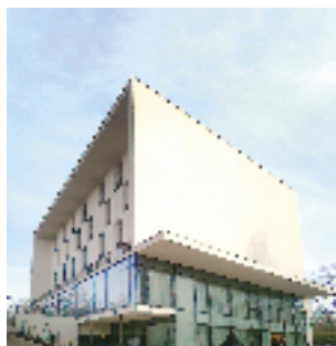
Echipament instalat: 2 ascensoare electrice, 8 pers., 8 stații; 200 kg, 3 stații Locație: Calea Floreasca nr. 165, sect. 1, București Client: DIESEL SERVCOM
