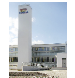
Echipament instalat: Ascensor hidrolic, 6 pers., 3 stații Locație: Centrul Social Toplița, Toplița, jud. Harghita Client: TCI CG CLUJ
