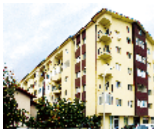
Echipament instalat: 3 ascensoare hidraulice, 5 pers., 6 stații Locație: Str. Drumul Fermei, nr. 62, Popești-Leordeni, jud. Ilfov Client: RĂDUCAN MIRELA
