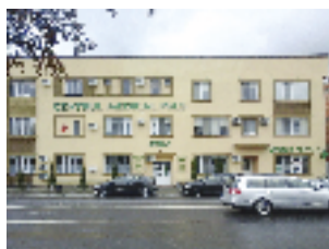
Echipament modernizat: Ascensor hidrolic, 1000 kg, 4 stații Locație: Str. Gheorghe Marinescu, nr. 4, Târgu-Mureș Client: ANDSER MEDICA
