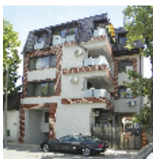
Echipament instalat: Ascensor hidrolic, 4 pers., 5 stații Locație: Str. Virgil Pleșoianu, nr. 110, sect. 1, București Client: CARAIAN LIVIU
