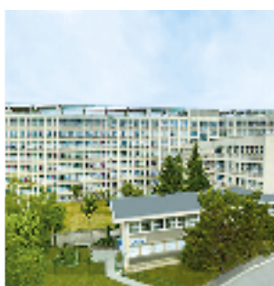
Echipament instalat: 3 ascensoare electrice, 20 pers., 7 stații; 100 kg, 2 stații (2) Locație: Str. Perchiului, nr. 1, Onești Client: ONLIF, SPITALUL MUNICIPAL ONEȘTI
