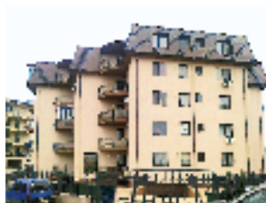
Echipament instalat: 4 ascensoare hidrolice, 5 pers., 5 stații (2); 5 pers., 6 stații (2) Locație: Str. Doinei nr. 58, sect. 5, București Client: BRÂNĂ ȘTEFAN FLORIN
