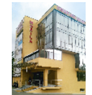
Echipament instalat: Ascensor hidrolic, 6 pers., 5 stații Locație: Str. Nicolae Bălcescu, nr. 48 B, Pitești Client: VENUS BCLMOB CLASS
