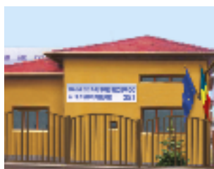
Echipament instalat: Ascensor hidrolic, 6 pers., 3 stații Locație: Calea Zărandului, nr. 43, Deva Client: TRANSILVANIA BUILDING, CASA DE AJUTOR RECIPROC A PENSIONARILOR
