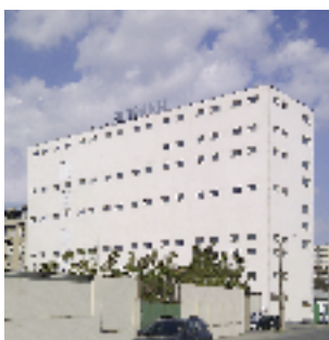
Echipament instalat: 2 ascensoare electrice, 16 pers., 5 stații, 1000 kg, 4 stații Locație: Str. Logofătul Tăutu, nr. 99, sect. 3, București Client: BIOFARM
