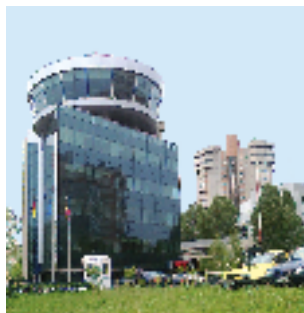
Echipament instalat: Ascensor marfă, 375 kg, 2 stații Locație: Str. Traian, nr. 68 A, Constanța Client: NBC LINE
