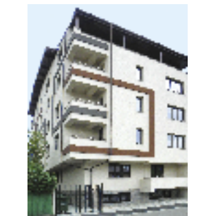
Echipament instalat: Ascensor hidrolic, 4 pers., 5 stații Locație: Str. Hispania nr. 22-24, sect. 2, București Client: TRANCĂ AMALIA ROMINA
