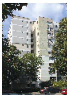
Echipament modernizat: 2 ascensoare electrice, 4 pers., 11 stații Locație: Str. Săndulești, nr. 3, bl. Z 40, sect. 6, București Client: ASOCIAȚIE PROPRIETARI
