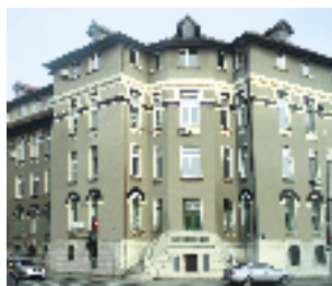
Echipament instalat: 4 ascensoare electrice, 8 pers., 6 stații; 6 pers., 6 stații; 16 pers., 6 stații (2) Locație: Calea Plevnei, nr. 142 - 144, sect. 6, București Client: ATHENAEUM CONSTRUCT SPITALUL WITTING
