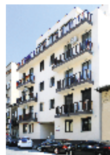
Echipament instalat: 2 ascensoare hidraulice, 4 pers., 6 stații Locație: Str. George Georgescu, nr. 37-39, sect. 4, București Client: TIMEA TRADE INVESTMENT
