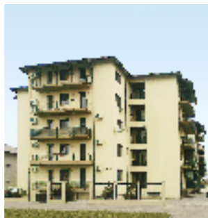
Echipament instalat: 2 ascensoare hidrolice, 6 pers., 6 stații Locație: Str. Cireșului, nr. 16 C, sect. 2, București Client: NICULAE I. VASILE DĂNUȚ
