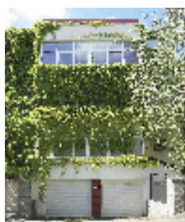
Echipament modernizat: Ascensor hidraulic, 3 pers., 3 stații Locație: Str. Pictor B. Iscovescu, nr. 13, sect. 1, București Client: ASOCIAȚIA DE PROPRIETARI
