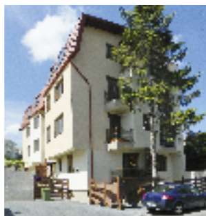
Echipament instalat: Ascensor hidrolic, 4 pers., 5 stații Locație: Str. Turnul Chindiei, nr. 5, sect. 1, București Client: STAVARACHE STELIAN
