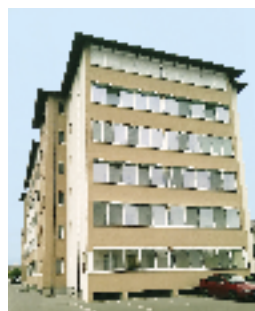
Echipament instalat: 2 ascensoare hidraulice, 6 pers., 7 stații Locație: Str. Toamnei, nr. 11, Pitești Client: NECULA ION
