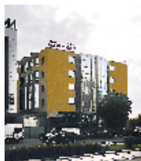
Echipament modernizat: 2 ascensoare hidraulice, 6 pers., 5 stații; 6 pers., 7 stații Locație: Calea Severinului, nr. 7 B, Craiova Client: HOTEL FLORMANG
