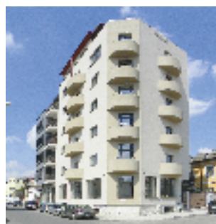
Echipament instalat: Ascensor hidrolic, 6 pers., 7 stații Locație: Str. Dragoș Vodă, nr. 47, sect. 2, București Client: PHOENIX REAL ESTATES
