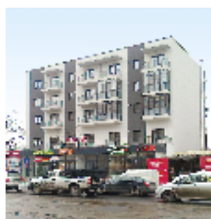
Echipament instalat: Ascensor hidrolic, 4 pers., 5 stații Locație: Bd. Basarabia, nr. 124, sect. 3, București Client: PITI CONSTANTIN
