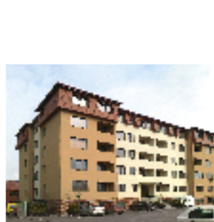
Echipament instalat: Ascensor hidrolic, 6 pers., 5 stații Locație: Str. Drumul Bacriului, nr. 99, sect. 6, București Client: GHEORGHE VASILE DANIEL
