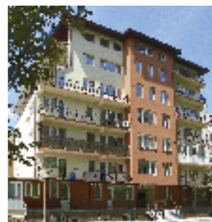
Echipament modernizat: Ascensor hidraulic, 5 pers., 7 stații Locație: Str. Centurii, nr. 7 B, sect. 6, București Client: DRUGĂN IULIA - CRISTINA
