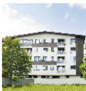
Echipament instalat: Ascensor hidrolic, 4 pers., 6 stații Locație: Str. Natașiei, nr. 59, sect. 1, București Client: DUMITRU LEONARD
