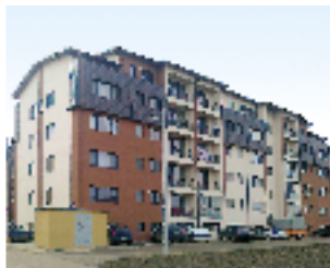
Echipament instalat: Ascensor hidrolic, 5 pers., 5 stații Locație: Str. Drumul Bacriului, bl. 15, sect. 6, București Client: SULTANA CONSTRUCT COMPANY
