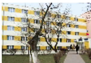
Echipament instalat: 2 ascensoare electrice, 100 kg, 2 stații; 100 kg, 3 stații Locație: bd. Tudor Vladimirescu, Iași Client: UPDATE CONSULT CAMPUS STUDENȚESC, CĂMIN T5
