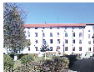
Echipament instalat: Ascensor hidraulic 13 pers., 5 stații Locație: str. Hermann Oberth, nr. 2-4, Sibiu Client: SINECON, SPITALUL CLINIC JUDEȚEAN
