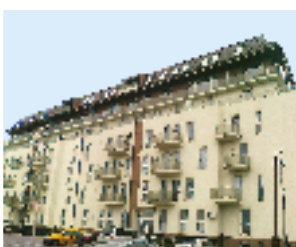
Echipament instalat: 2 ascensoare electrice, 6 pers., 7 stații Locație: Str. Gării, nr. 1, bl. 2, com. Dobroești-Fundeni, Jud. Ilfov Client: URBAN EXPERT CONSTRUCT
