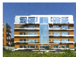
Echipament instalat: Ascensor hidrolic, 4 pers., 6 stații Locație: Str. Liliacului, nr. 55, bl. B, sect. 1, București Client: ZOOM ADVERTISING
