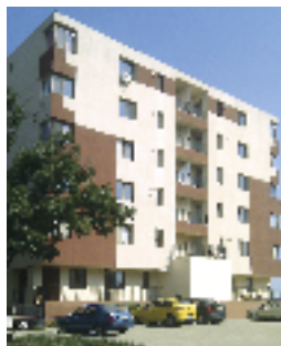
Echipament instalat: Ascensor hidrolic, 4 pers., 5 stații Locație: Str. Dâmboviței, nr. 40, sect. 6, București Client: PUCIANU CLAUDIA
