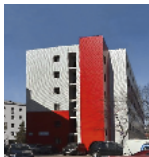
Echipament instalat: Ascensor hidrolic, 4 pers., 4 stații Locație: Str. Veniamin Costache, nr. 24, Târgu Neamț Client: ROMCONSTRUCT HOLDING GRUP
