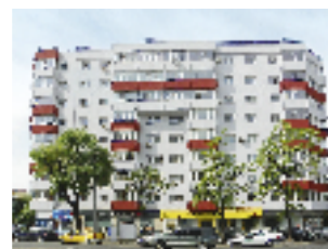
Echipament modernizat: 4 ascensoare electrice, 4 pers., 9 stații Locație: Bd. Ion Mihalache, nr. 109, bl. 13 A, sect. 1, București Client: ASOCIAȚIA DE PROPRIETARI
