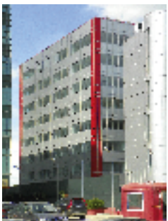
Echipament instalat: 4 ascensoare electrice, 8 pers., 10 stații (2); 8 pers., 11 stații (2) Locație: Șos. Pipera-Tunari, nr. 1, sect. 2, București Client: ADEXIM MODELCOM
