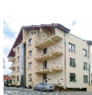
Echipament instalat: Ascensor hidrolic, 400 kg, 4 stații Locație: Str. Mitropolit Varlaam, nr. 88, sect. 1, București Client: BĂRBUCEANU GEORGETA
