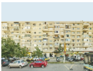
Echipament modernizat: 5 ascensoare electrice, 4 pers., 8 stații Locație: Str. Calea Griviței, nr. 206, bl. K, sect. 1, București Client: ASOCIAȚIA DE PROPRIETARI
