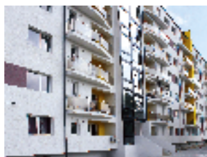
Echipament instalat: 2 ascensoare electrice, 5 pers., 8 stații Locație: Bd. Nicolae Grigorescu, nr. 121, București Client: SZTANKOVICS COSMIN
