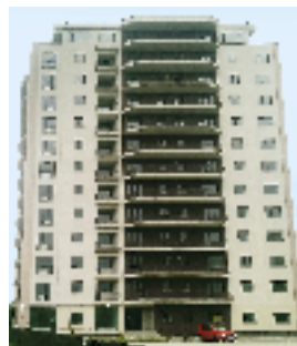
Echipament instalat: 2 ascensoare electrice 6 pers., 14 stații; 10 pers., 14 stații Locație: Str. Depozitelor, nr. 29, Pitești Client: TRANSIM GRUP
