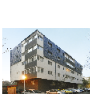
Echipament instalat: Ascensor hidrolic, 6 pers., 5 stații Locație: Str. Dorneasca, nr. 11 A, sect. 5, București Client: I&A NIȚU SISTEMS
