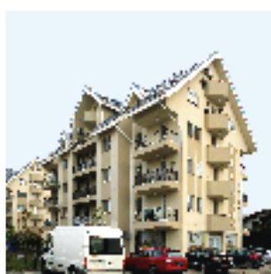
Echipament instalat: Ascensor hidrolic, 3 pers., 5 stații Locație: Str. Drumul Fermei, nr. 103, com. Popești-Leordeni Client: KLUG INVEST
