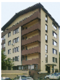
Echipament instalat: Ascensor hidrolic, 4 pers., 6 stații Locație: Str. George Valentin Bibescu, nr. 7A, sect. 1, București Client: DORU STAN
