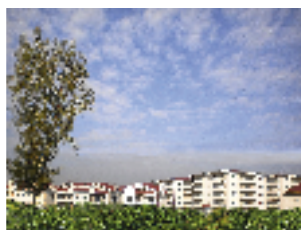
Echipament instalat: 10 ascensoare hidraulice, 5 pers., 6 stații Locație: Str. Antiaeriana, Nr. 6, sect. 5, București Client: ISORAȘ TECHNOLOGY
