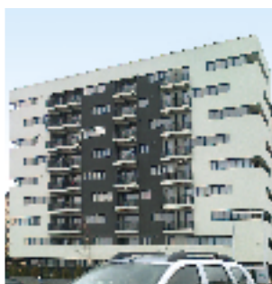
Echipament instalat: 2 ascensoare electrice, 5 pers., 10 stații Locație: Str. Tineretului, nr. 2, com. Chiajna, sat Dudu, jud. Ilfov Client: NWF INTERNATIONAL
