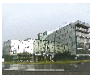
Echipament modernizat: Ascensor hidrolic; 4 pers., 7 stații 3 ascensoare electrice, 8 pers., 8 stații (2); 100 kg, 2 stații Locație: Șos. București-Ploiești, nr. 218, com. Tâncăbești, jud. Ilfov Client: HOTEL MIRAGE SNAGOV
