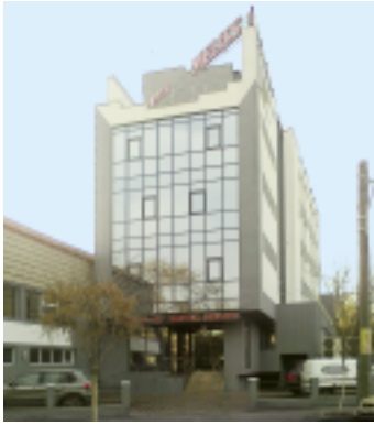
Echipament instalat: Ascensor hidraulic, 6 pers., 6 stații Locație: Bd. Carol, nr. 104, Craiova Client: GOLDEN LIX STYLE
