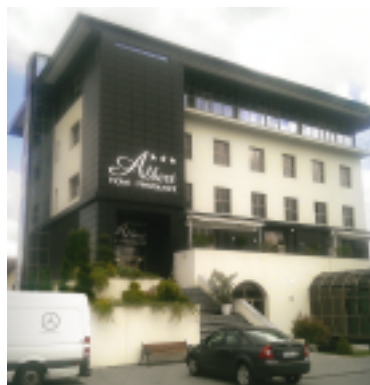
Echipament instalat: Ascensor hidraulic, 6 pers., 5 stații Locație: Bd. Republicii, nr. 164, localitatea Ploiești Client: STROESCU CLAUDIU
