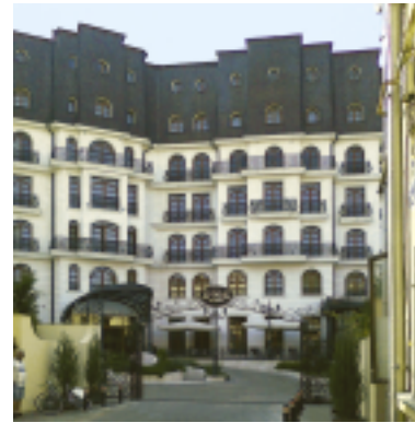
Echipament instalat: Ascensor electric, 200 kg, 3 stații Locație: Str. Aurora, nr. 17, Hotel Epoque, sect. 1, București Client: D&M PERFECT REAL ESTATE
