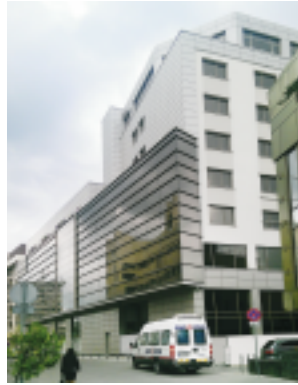
Echipament instalat: Ascensor electric, 6 pers., 5 stații Locație: Str. Tache Ionescu, nr. 6, Ploiești Client: TURIST
