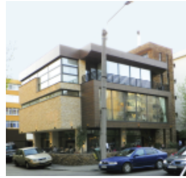
Echipament instalat: Ascensor electric, 200 kg, 4 stații Locație: Str. Petre Ispirescu, nr. 9 B, sect. 5, București. Client: SANDA LAUREL DUMITRU
