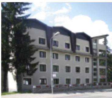
Echipament instalat: Ascensor hidraulic, 6 pers., 6 stații Locație: Str. Valea Lungă, nr. 8, Poiana Brașov Client: J. T. EUROCONSTRUCT HOTEL RIZZO BOUTIQUE
