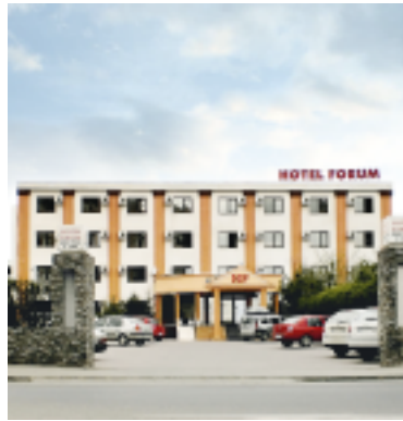
Echipament instalat: Ascensor hidraulic, 5 pers., 4 stații Locație: Str. Gheorghe Doja, nr. 215 A, Ploiești Client: REDEXPRO, HOTEL FORUM
