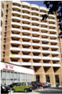
Echipament modernizat: Ascensor electric, 6 pers., 15 stații; Locație: Complex Hotelier Afodita, Băile Herculane Client: RESTAURANT BACOLUX
